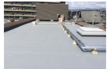
某施設屋上ガレージ工事(ウレタン吹付防水)
