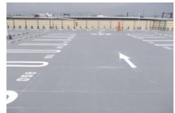
某施設屋上ガレージ工事(ウレタン吹付防水)
